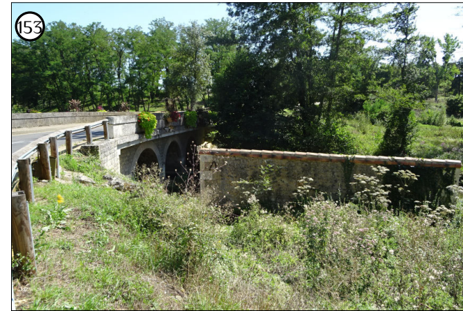
Mise en scène bucolique au niveau d'un franchissement au-dessus du ruisseau de la Boivre non loin de Vouneuil-sous-Biard
