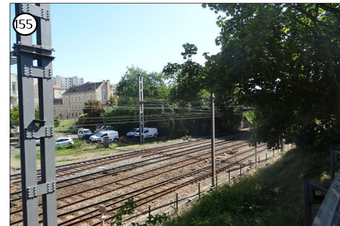
155 Infrastructures de la gare de Poitiers
